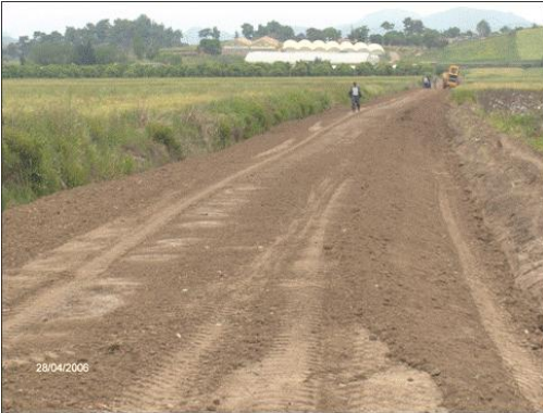
GEREKEN EĞİMİ VERİP DÜZELTİK
