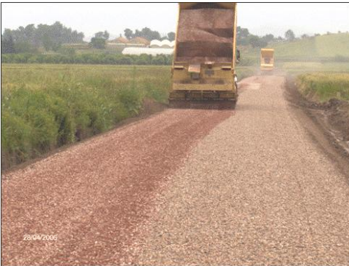
İSTEK ÜZERİNE 2,5 cm B SINIFI ÇAKIL İLE KAPLADIK
