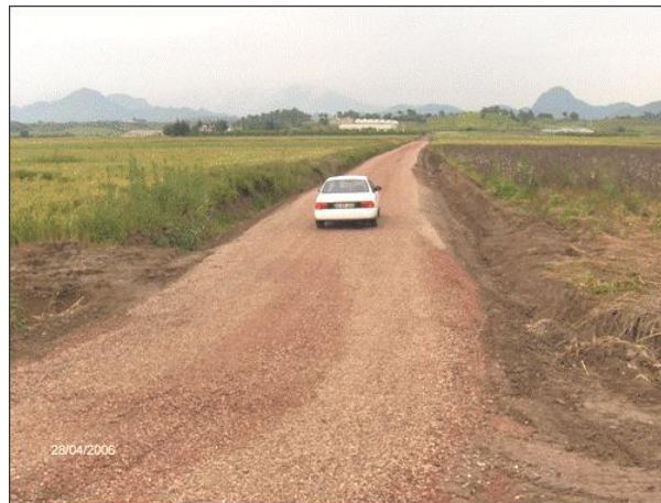
TRAFİĞE AÇILMIŞ YOL
